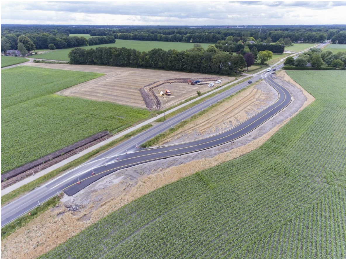
Afbeelding 1. Luchtfoto bypass Turnhoutseweg
